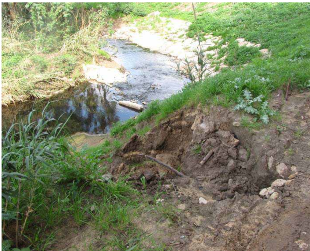
תרשים 27: ביצורי אבן בפיתול נחל והתחתרות חדשה מעל הביצור.
