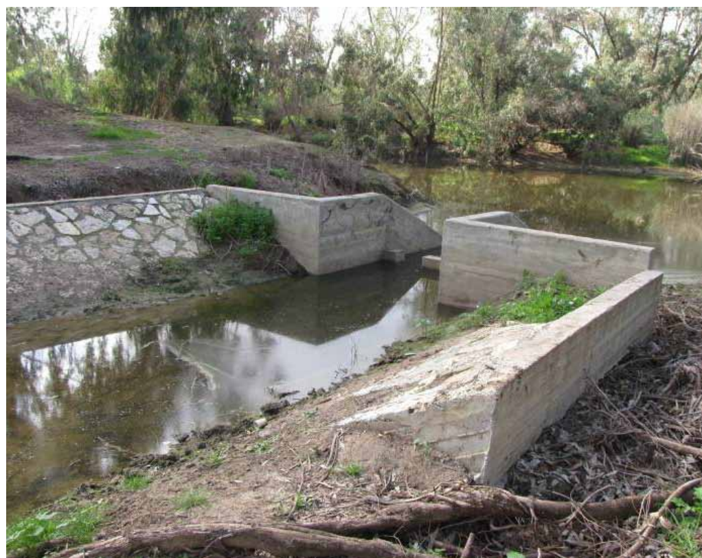
תרשים 24: מתקן כניסה מתעלת ניקוז לקטע מלוח של נחל שורק.
