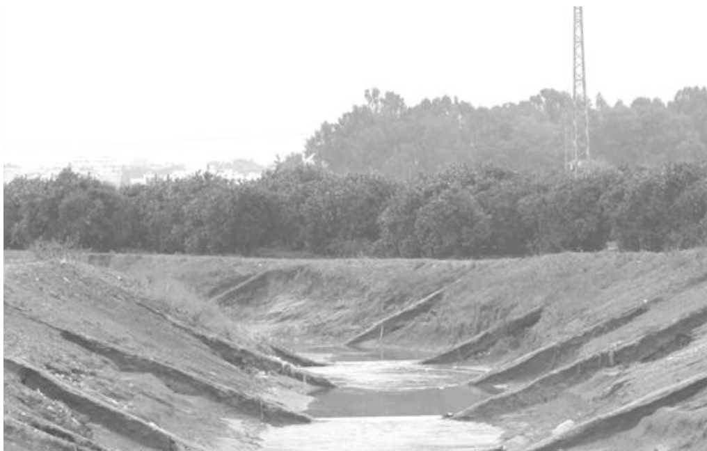
תרשים ו: מפתנים חשופים במעלה אפיק נחל פולג (מאת התחנה לשימור קרקע וניקוז).
