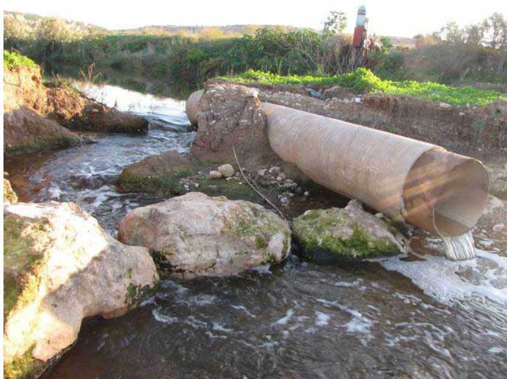
תרשים 29: מתקן הרמת מפלס ותפיסת מי נחל.
