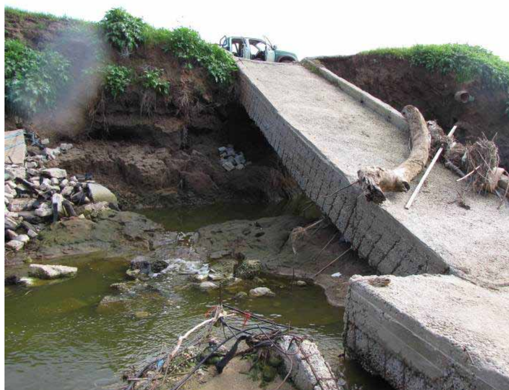
תרשים 32: מתקן בטון שקרס עקב התחתרות וגריפת הגדות.
