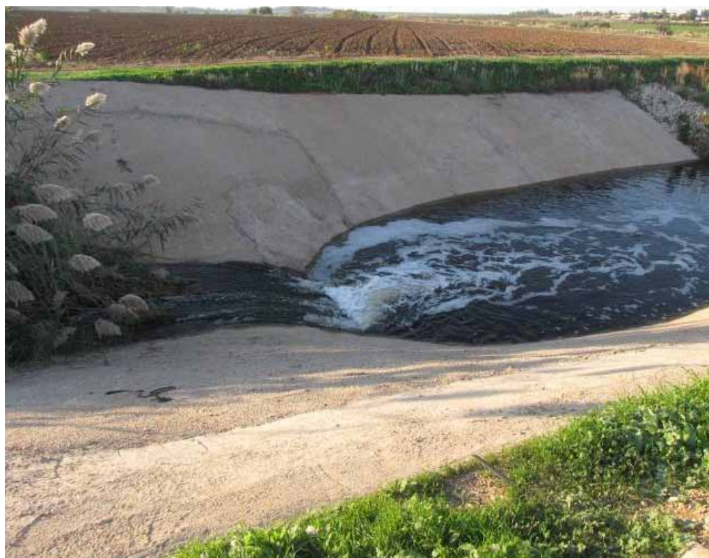
תרשים 28: מפל בטון (אחד מסדרה) לשמירה על שיפוע אורכי מתון של אפיק הנחל.
