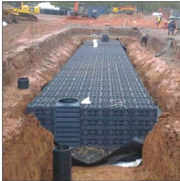
תמונה 3.1: שלב בהקמת שרול אורכי מיחידות פלסטיק (מתוך מצגת חברת אגרון)
