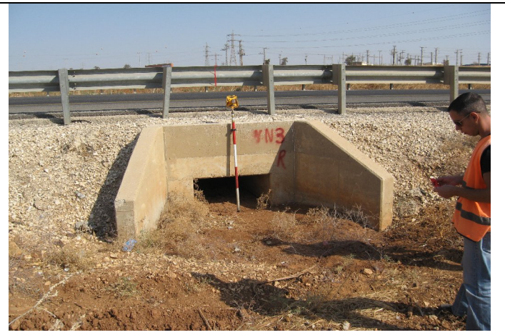
תמונה מס' 23. יציאה למעביר מים מס' 3 (אגן מס' 30) - המעביר נסתם בסחף חלקית
