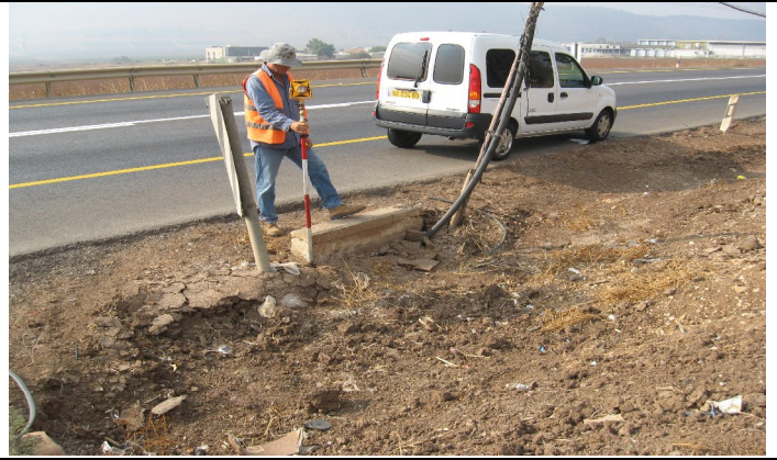
תמונה מס' 21. כניסה למעביר מים מס' 27 (אגן מס' 10) - המעביר כולו נסתם בסחף
