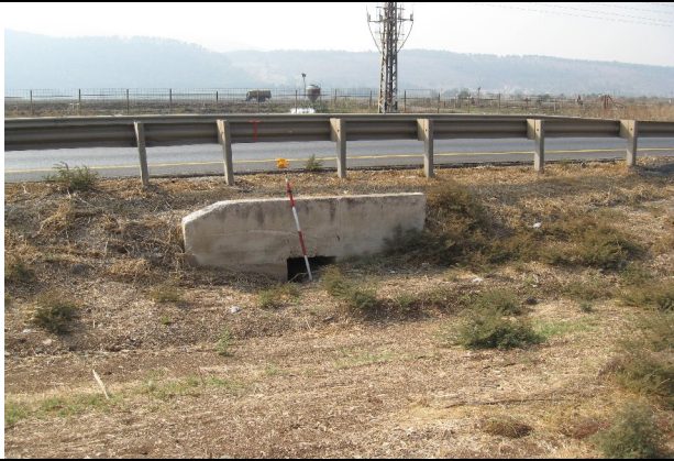
תמונה מס' 22. כניסה למעביר מים מס' 31 (אגן מס' 6) - המעביר נסתם בסחף חלקית
