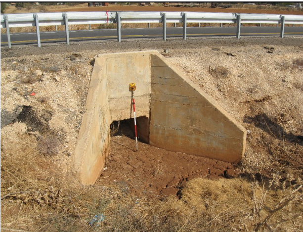
תמונה מס' 24. כניסה למעביר מים מס' 8 (אגן מס' 26) - המעביר נסתם בסחף חלקית
