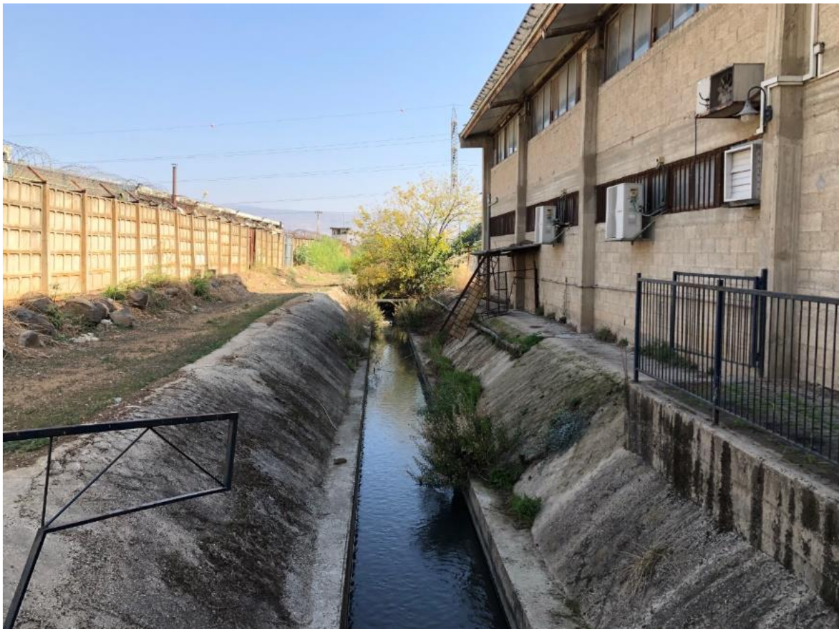
נחל עין זהב – אזור החיבור לתעלה המערבית, תעלה מיושרת ומבוטנת (ליגמ 2020)
