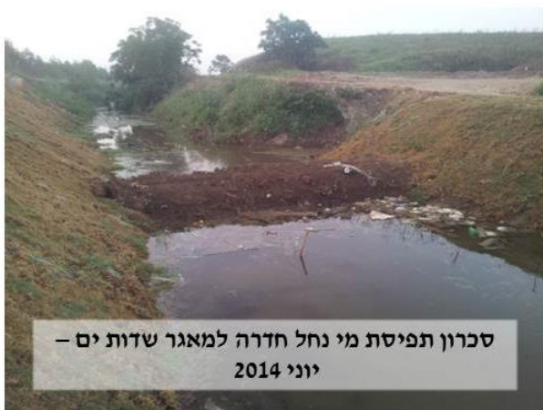
איור 31. סכרונים לתפיסת זרימות בסיס בנחלים חביבה וחדרה למאגר שדות-ים, 20 ביוני 2014
