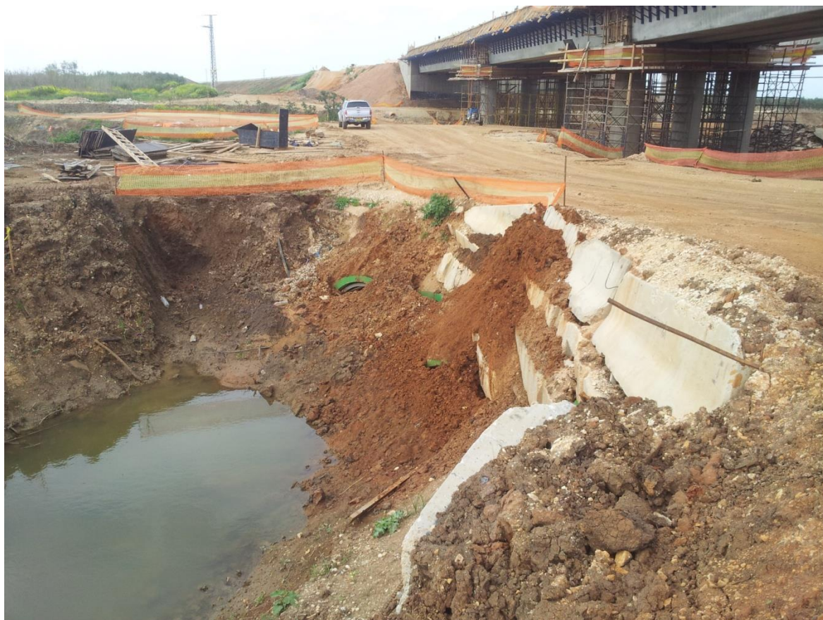
איור 30. חסימת אפיק נחל חדרה בסמוך לעבודות כביש 9 לשם העלת מפלס לשאיבה למאגר שדות ים, 18 במרץ 2014
