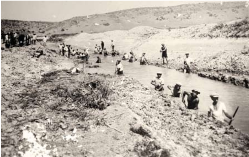
איור 9. חפירת תעלות בנתיב הנחל
