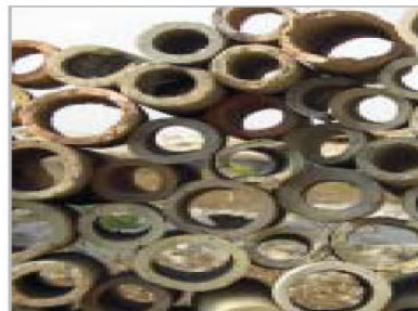
צינורות חרס מתחילת המאה שיצרו לשם נקוז ביצות הכברה, ובית היוצר שלהם נחשף ושומר באתר
