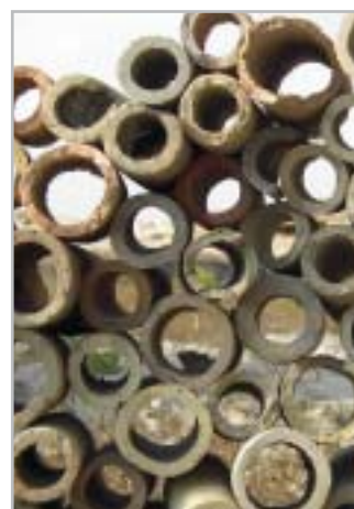
■ צינורות חרס מתחילת המאה שיוצרו לשם ניקוז ביצות הכברה, ובית היוצר שלהם נחשף ושומר באתר
