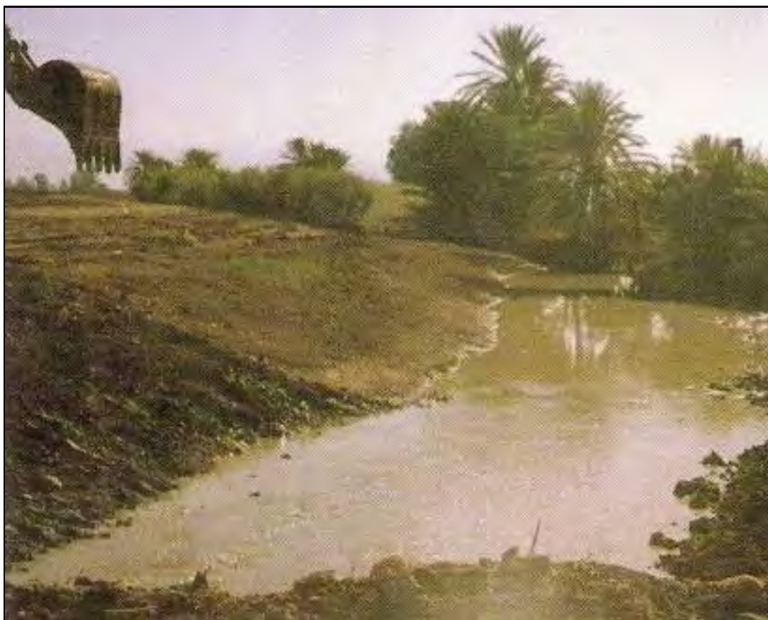
תמונה 2: עבודות עפר להוצאה ופינוי של סחף – נחל חרוד (מתוך תה"ל, 2000).
