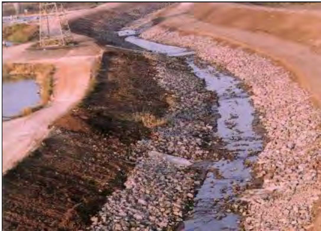
תמונה 4 : רוחב טיפול לביצוע פעולות התחזוקה: ערוץ הנחל, הגדות ודרכי השירות – נחל חרוד (מתוך תה"ל, 2000).
