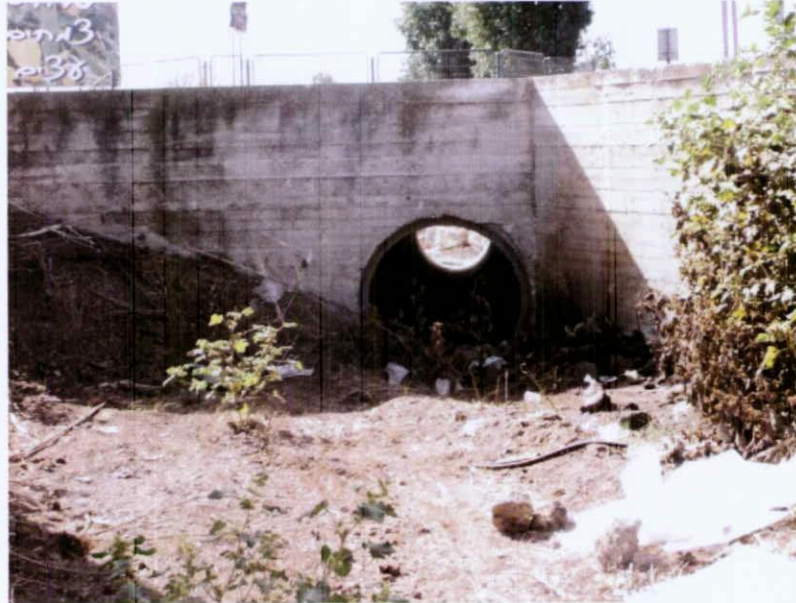
תמונה מס' 1: מעביר מים מס' 1 בקוטר 1 מטר.
