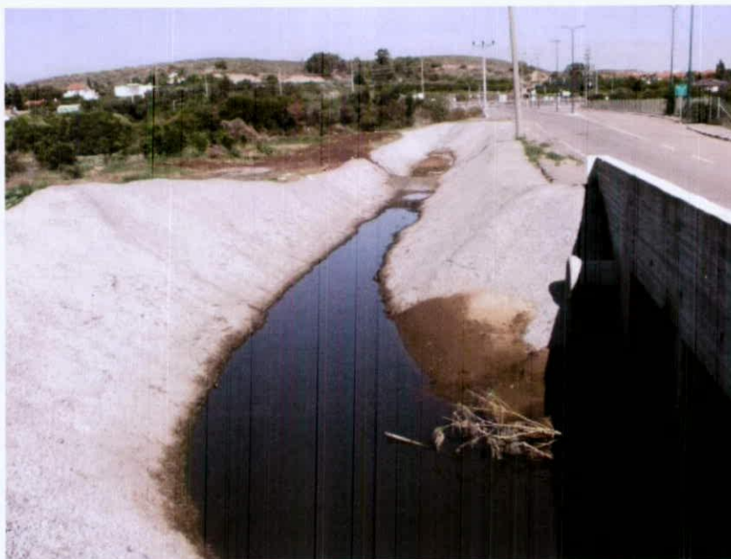
תמונה מס' 14 : תעלת נחל נס ציונה, הסדרה זמנית ליד מעביר מספר 8. כושר הולכה של התעלה כ - 20 מ"ק לשניה.
