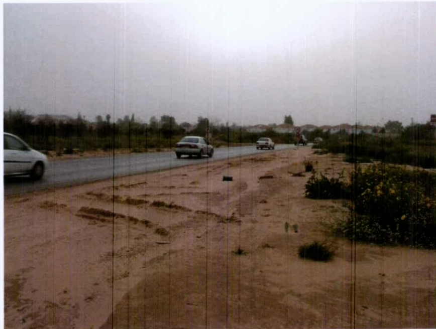
תמונה מס' 8: סימני הצפות מעל כביש נס ציונה – באר יעקב באזור הכניסה למובל הניקוז הראשי של נס ציונה, (באזור נקודה מס' 5). שים לב לסחף הרב של קרקע החמרה, שכיסה את תעלת הכביש.
