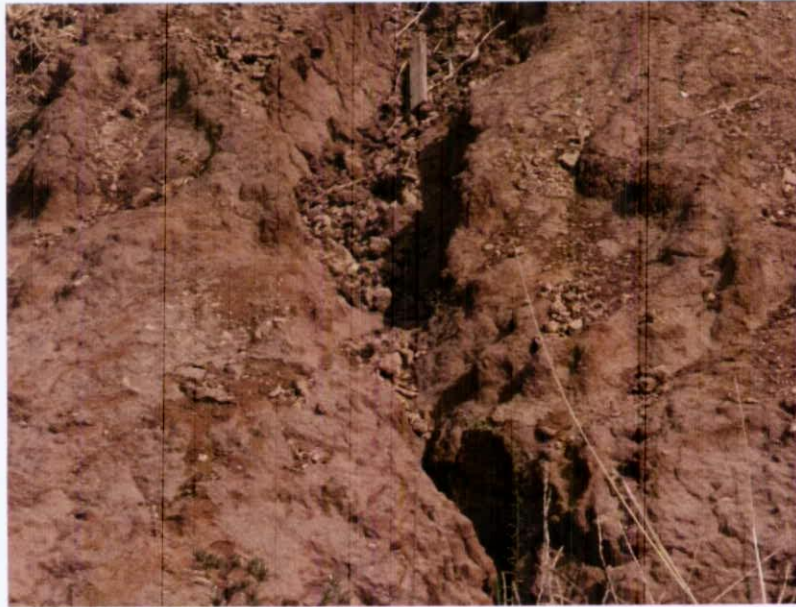
תמונה מספר 7: התחתרות מים בחמרה החשופה.
