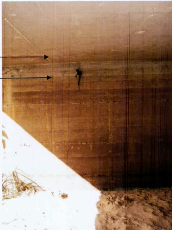
תמונה מס' 10: סימני זרימה בתוך מעביר מים מס' 6 - עד לרום העליון של המעביר. (הזרימה צובעת בצבע חמרה את בטון המעביר).
