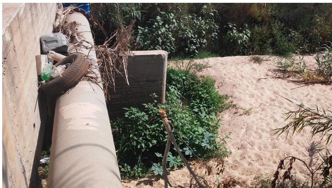
תמונה 6: מעביר מים שני, סחף רב של חול דיונה, צמחיה ושאר עצמים עד גובה של שני מטר (המים עברו מעל הכביש)
