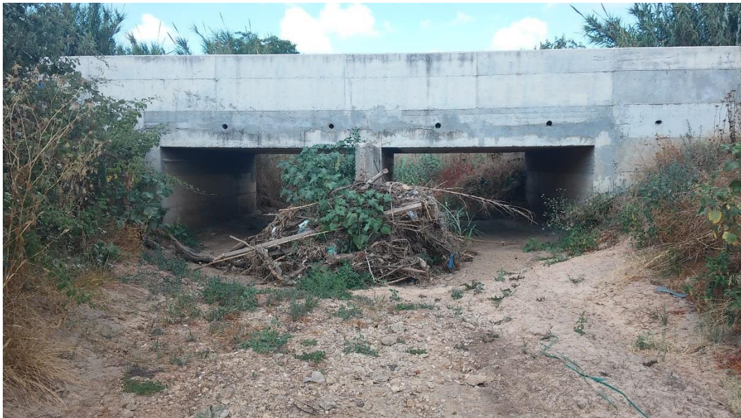
תמונה 4: מעביר מים ראשון מתחת לדרך עפר, סחף רב של חול וצמחיה
