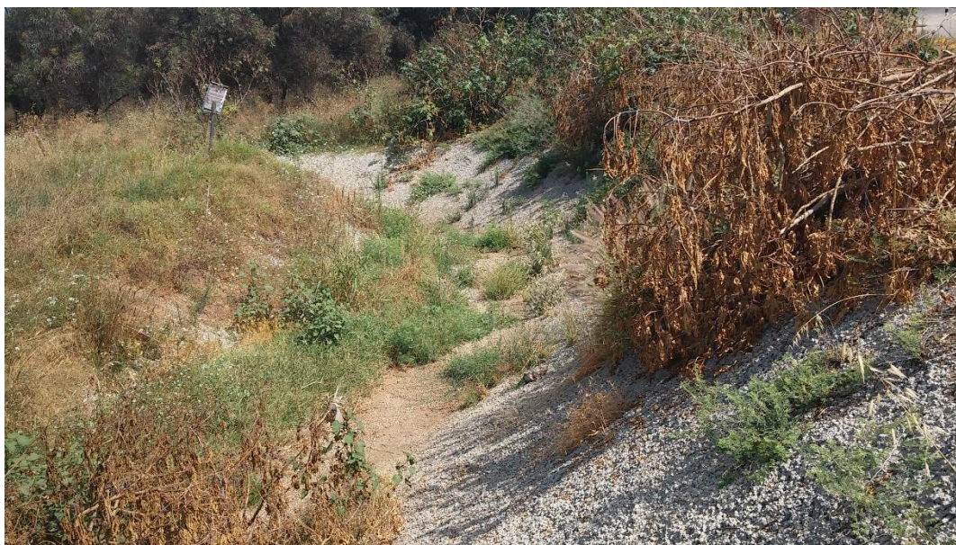
תמונה 8: תעלת הנחל בהמשך מדופנת בטון בפניה חדה שמאלה, התעלה קטנה ביחס לתעלה במעלה
