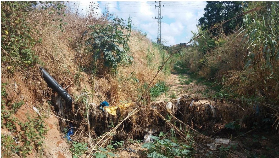
תמונה 2: צינור מים החוצה את הערוץ ותופס סחף צמחייה רב
