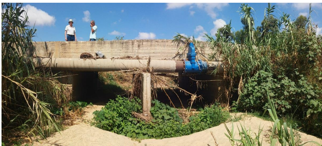
תמונה 5: מעביר מים שני מתחת לדרך סלולה (רחוב האלופים), סחף רב של חול דיונה וצמחיה
