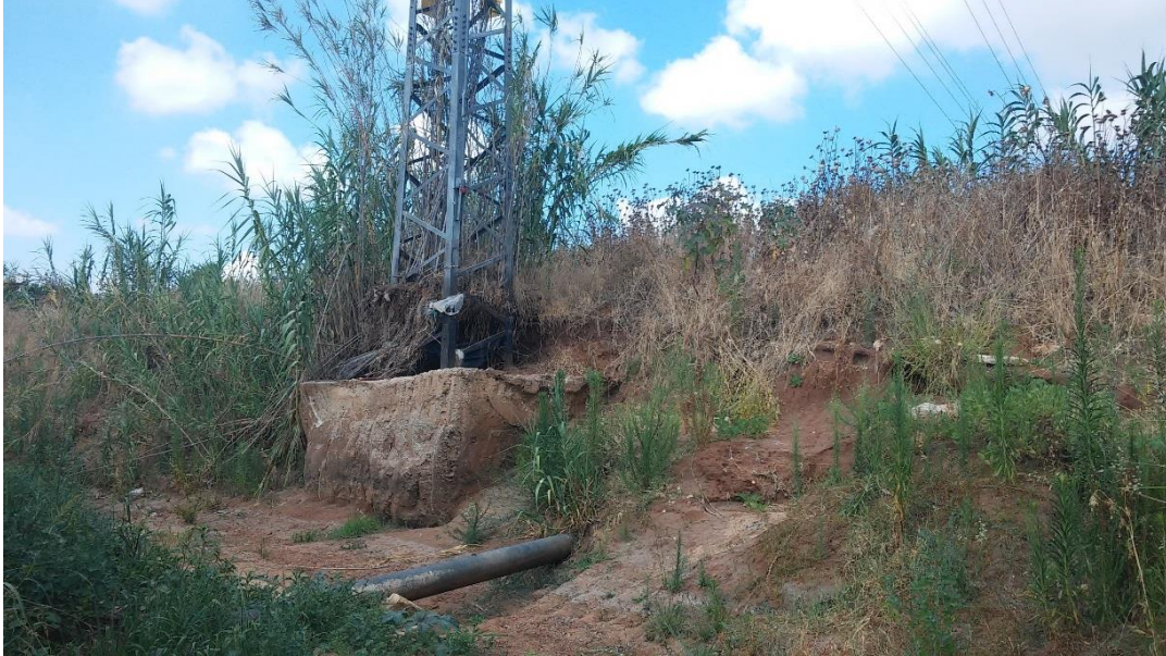
תמונה 1: אזור יציאת מעביר המים מתחת לכביש 4303 המחבר את התעלה בדרך השושנים לנחל
