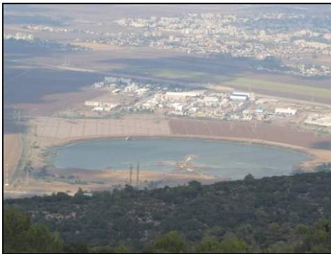
תמונה 19 – בריכת "נשר – כלל" המערבית – מתוכננת כמלכודת סחף לסדימנט הקישון
