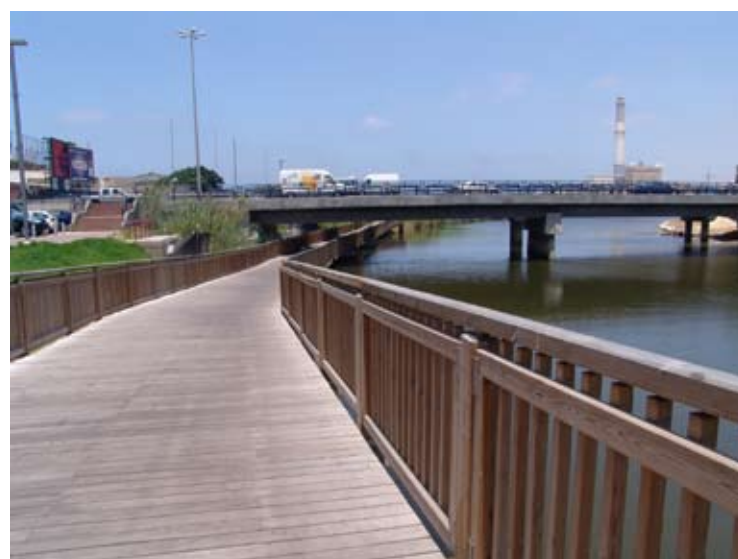
הטיילת לאורך נחל הירקון הועברה במפלס התחתון מתחת לגשר, וכך אפשר לשמור על רציפות המעבר
