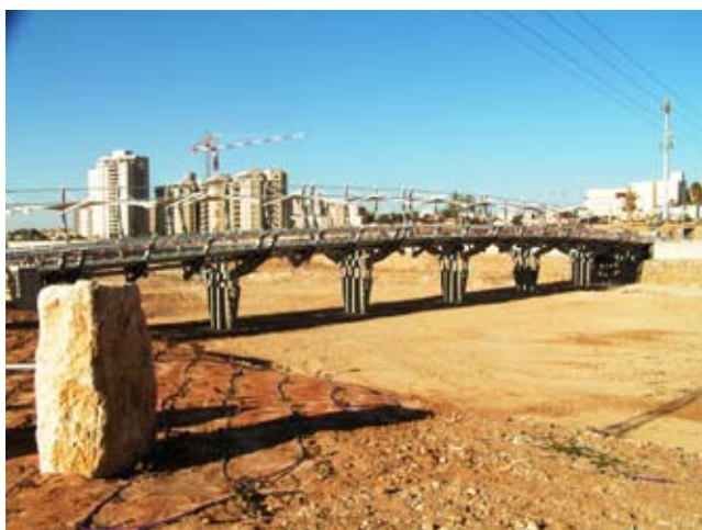
גשר הצינורות בפארק נחל באר שבע. בתמונה הימנית – הצינורות לפני הפיכתם לגשר
