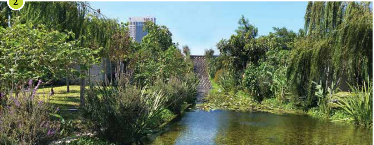
גג ירוק אינטנסיבי על בניין צ'מפיון בבני ברק. הגן האינטנסיבי נשתל בשנת 2014 בקומה 6 מעל החניון ובו מרשאות, עצי נוי וצל, שיחים, מפל, בריכת נוי, משטחי עץ ופינות ישיבה. שטחו הכולל 1,600 מ"ר. תשתית: גרנון | מערכת תשתית: OPTIGREEN | צילום: באדיבות רוני בנין, גרנון
