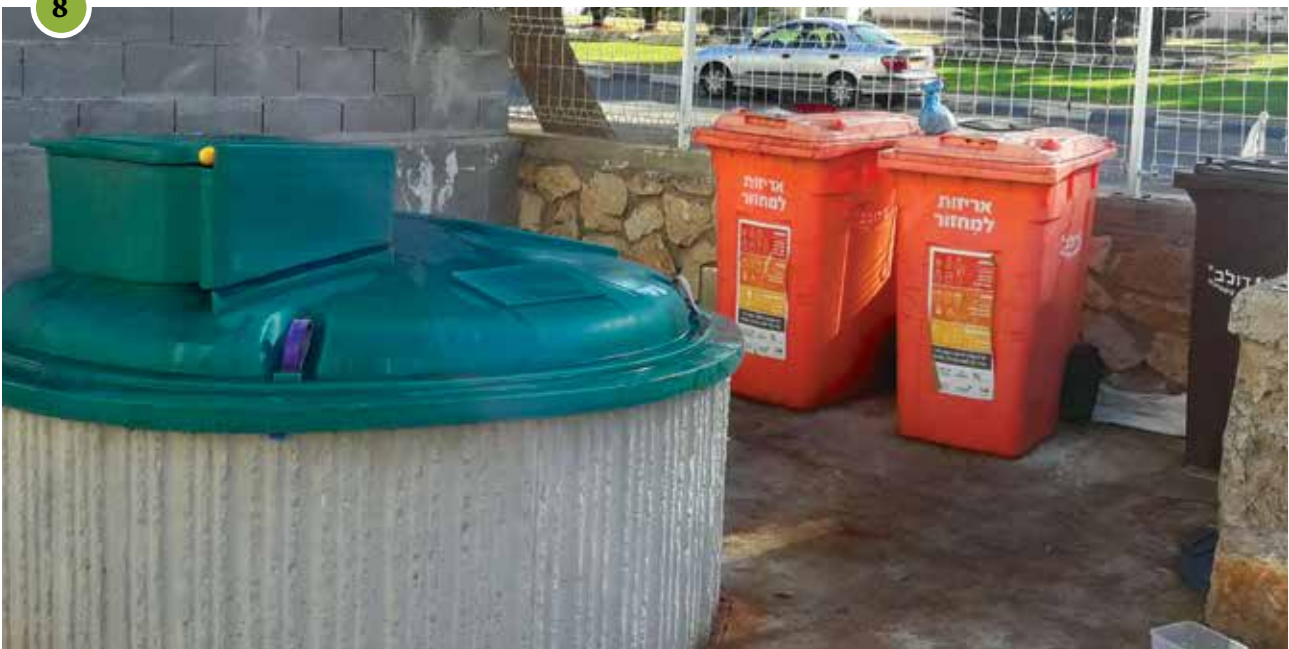
מכלי אצירה למחזור סמוך לכלי האצירה לשאריות, במקרה זה טמוני קרקע. מעבר לכלי אצירה גדולים מבטיח יעילות בפינוי הפסולת צילום: ירון רוקמן
