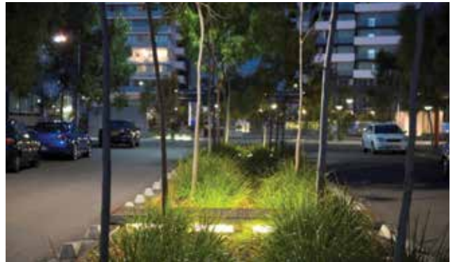
ביופילטר בעיר מלבורן שבאוסטרליה, במופע נוף של אי-תנועה מונמך המנקז את שני צידי הכביש. בישראל עדיין לא הותקן ביופילטר כזה. התמונה באדיבות ד"ר ירון זינגר
