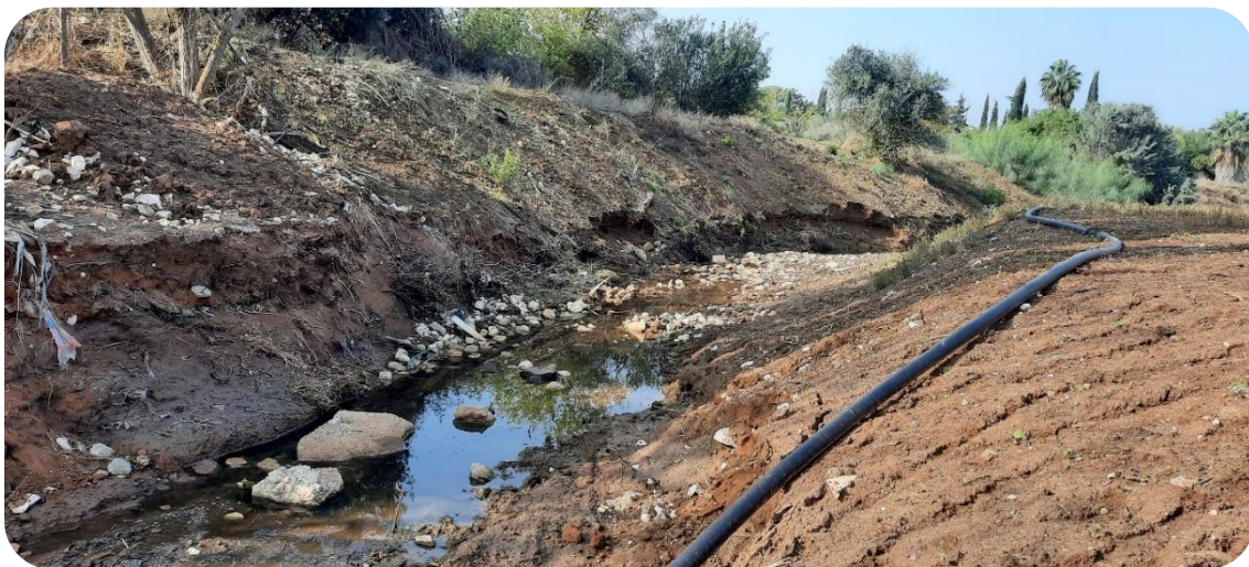
צילום 7 – סחיפת קרקע וחלק ממערכת ההשקיה עקב זרימות בנחל שפירים טרם השלמת זריעות מיני בר ומינים חקלאיים לצורך ייצוב גדות הנחל בצומח (צילום: שגב טמיר, נובמבר 2022)
