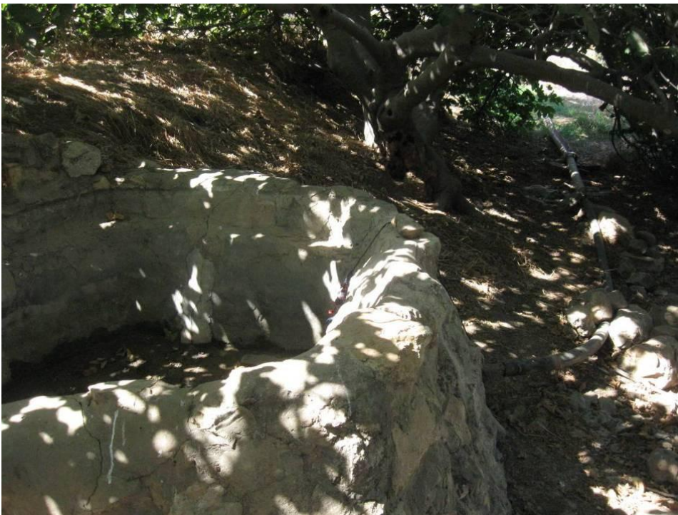
תמונות 322 ו-323: בתמונה העליונה תעלת הבטון המוליכה את מי המעיין לבריכה הבאה. בתמונה התחתונה הבריכה השנייה והצינור שיוצא מקיר הבריכה ומוליך את המים להשקיה של גידולים חקלאיים.
