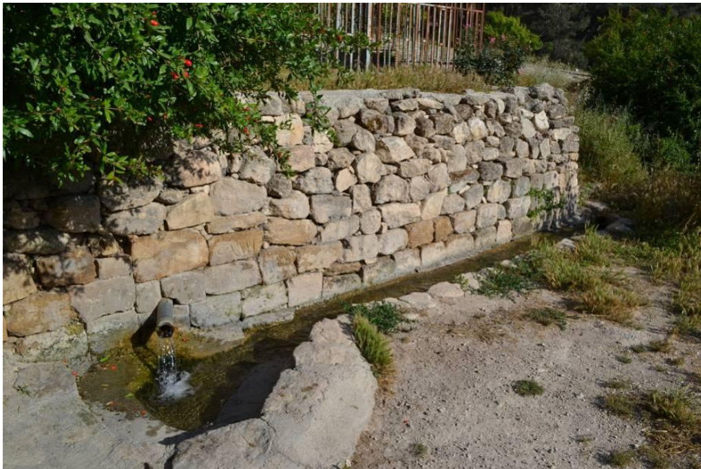
תמונות 175 ו-176: בתמונה העליונה בריכת הבטון של עין מקב. ניתן לראות בקיר הנגדי של הבריכה את הצינור שמוביל את מי המעיין. ברקע שביל העפר שמוביל לאתר וחניית הרכבים מאחורי הגדר. בתמונה התחתונה המים נשפכים לתעלת בטון פתוחה וזורמים לכיוון המפלס התחתון.
