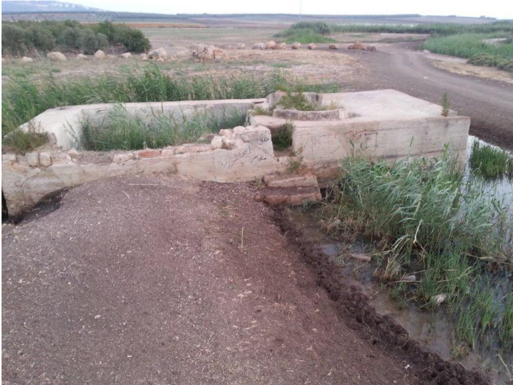
תמונה 118: באר אנטיליה ששימשה בעבר את חקלאי כפר אכסל לשאיבת מים למטעים והשדות. המבנה מוזנח ונראה שאינו מטופל. המים גולשים מהבאר מסביב למבנה. בבריכה יש פריחה של עדשת מים. ברקע אזורי נביעה נוספים בעינות אכסל.
