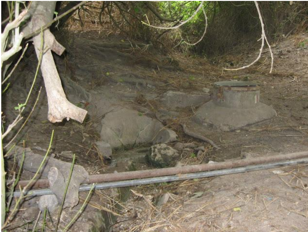
תמונה 275: בצד ימין מבנה בטון בולט מהקרקע ועליו מכסה ברזל. משמאל למבנה הנקודה בה מתחילה הזרימה של המעיין. המים זורמים בתעלת הבטון אל נחל קיני (התעלה נראית תחת שני צינורות מתכת).
