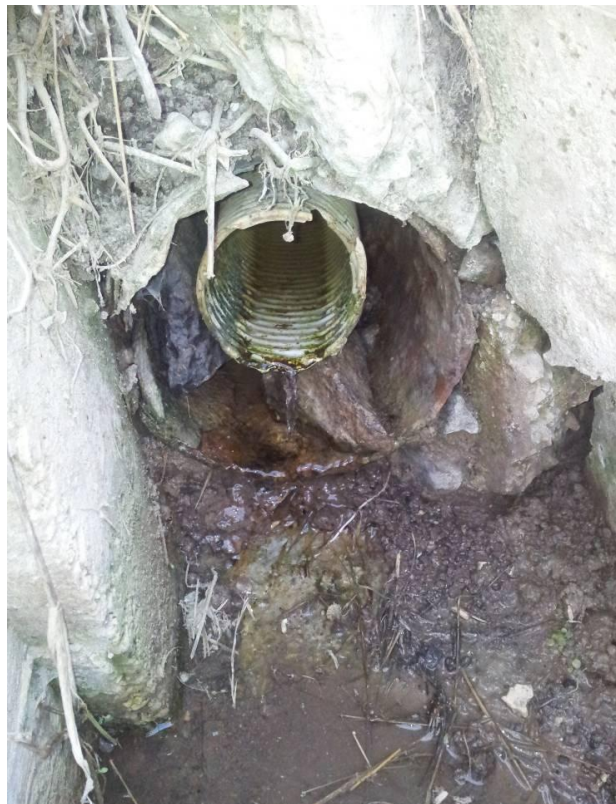
תמונות 202 ו-203: בתמונה העליונה מבט אל מבנה הבטון והאבנים שהוכן מתחת לדרך העפר דרכו זורמים מי עין עלוק בצינור אל תעלת הניקוז. בתמונה התחתונה זרימת המים דרך צינור הפלסטיק וצינור המתכת.
