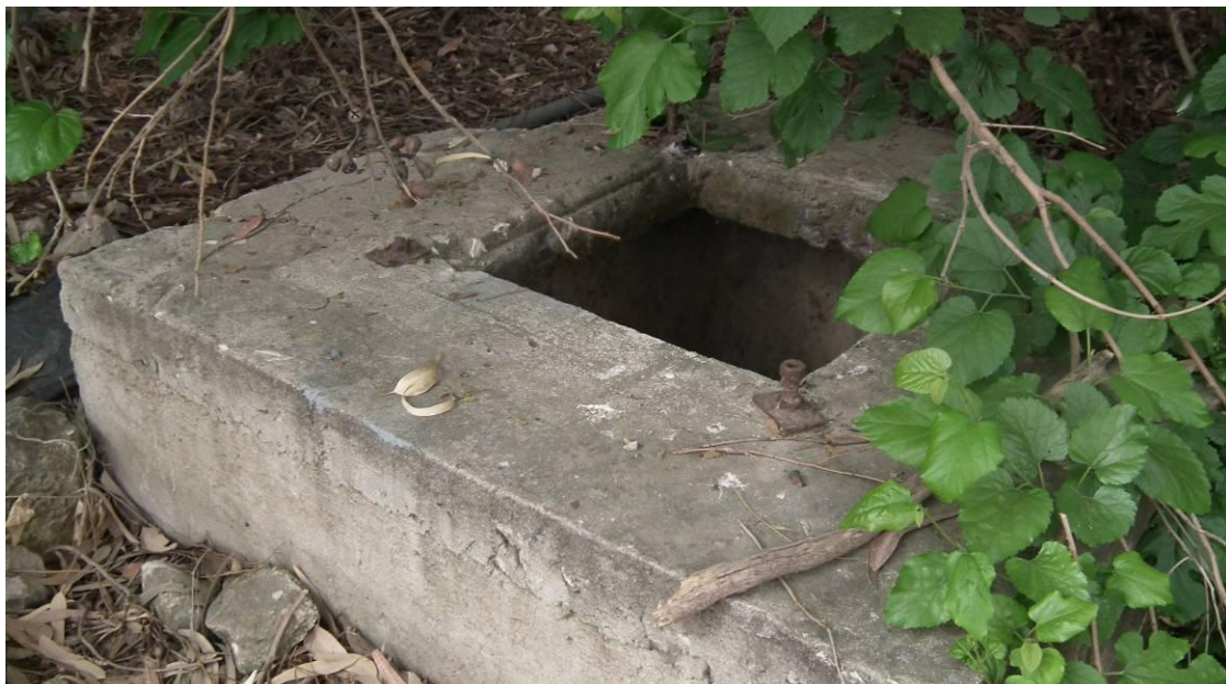
תמונה 333: קוביית בטון ובתוכה חדר ותחילתו של צינור המוביל את מי המעיין למפגש "מעיינות היוגב".
