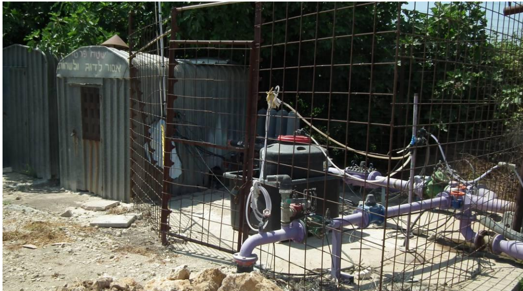
תמונות 18 ו-19: בתמונות העליונה והתחתונה נראה מבנה הפח שבו מותקנת המשאבה, הצנרת ומערכות סינון להשבחת המים לפני שהם מוזרמים לשטחים החקלאיים של קיבוץ שער העמקים.
