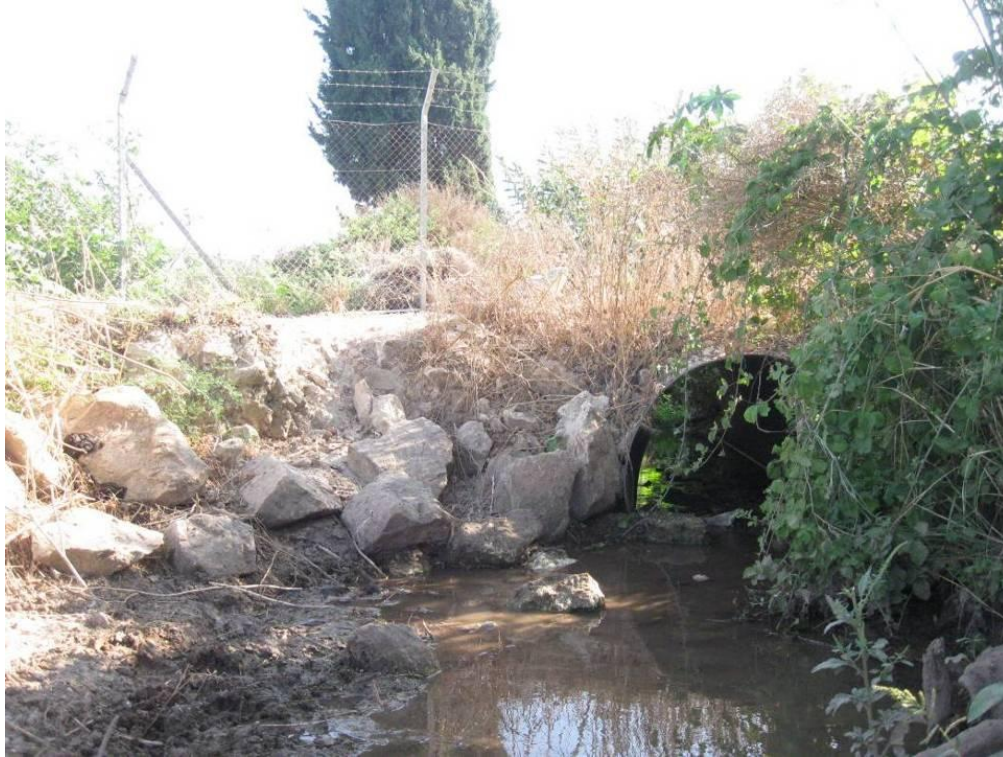
תמונה 351: מעביר המים דרכו עוברים מי המעיין תחת גדר המושב ודרך העפר ההיקפית ומתנקזים לנחל מדרך.
