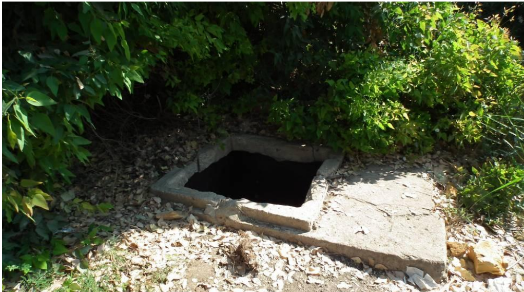
תמונות 295 ו-296: בתמונה העליונה העדר של נהלל רועה בעין שיכה בשנת 1927 (מקור: ארכיון מושב נהלל). בתמונה האמצעית מבט כללי על בית המשאבה והגן שהוקם במקום. מאחוריו בריכה מלאכותית שמקבלת מים מהמעייין. בתמונה התחתונה שוחת הבטון הסמוכה, אליה וממנה זורמים המים גרוויטציונית לאגירה והשקיה של השדות.
