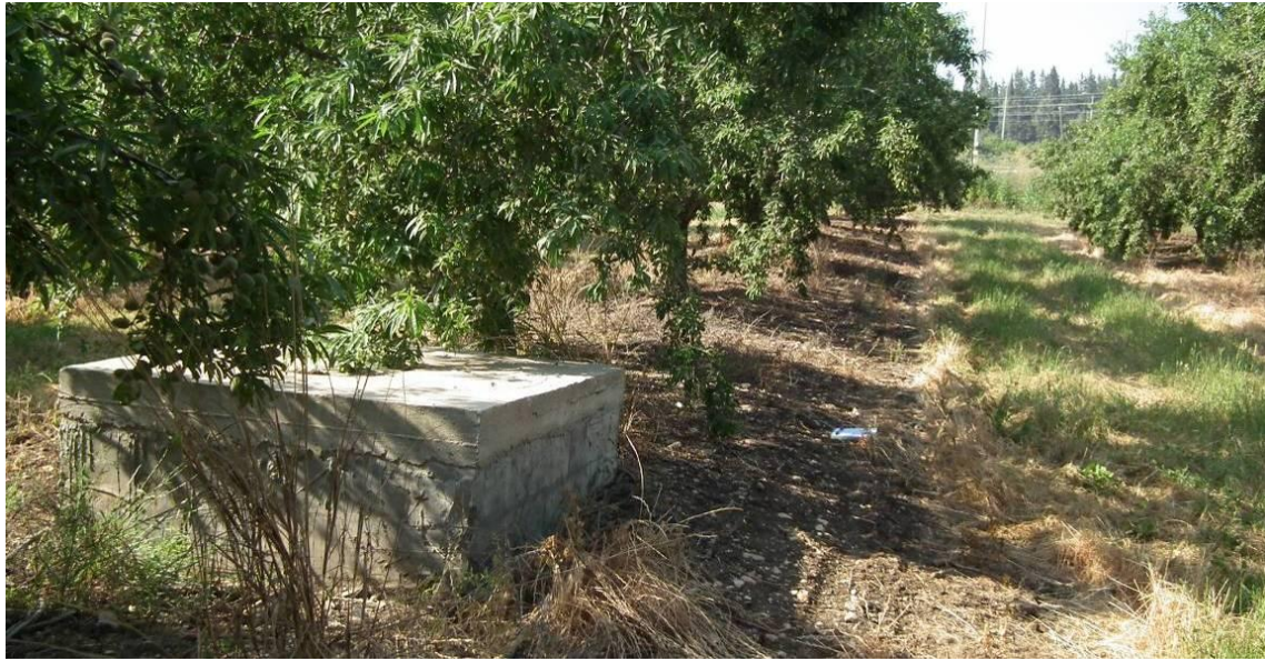
תמונה 256: בצידה השמאלי של התמונה ניתן להבחין בקוביית בטון בין עצי השקד. דרך קובייה זו עובר הצינור המוביל את מי עינות ניסנית אל מפגש "מעיינות היוגב".
