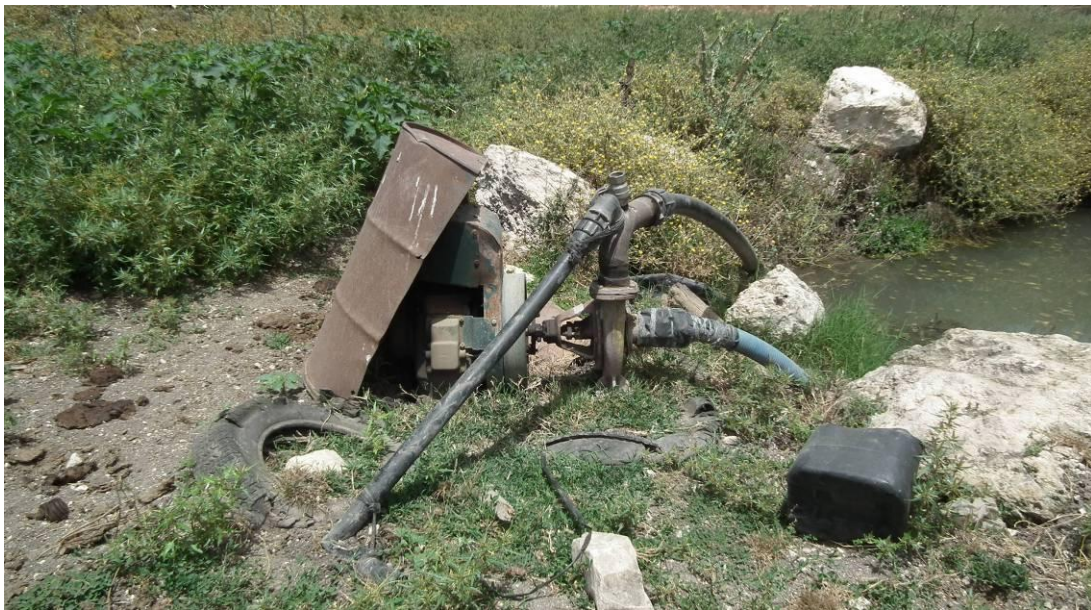
תמונות 2 ו-3: בתמונה העליונה ניתן לראות את המשאבה, הגנראטור והצנרת הטבולה בבריכה. בתמונה התחתונה מבט אל ערוץ הזרימה בוואדי במורד המעיין.
