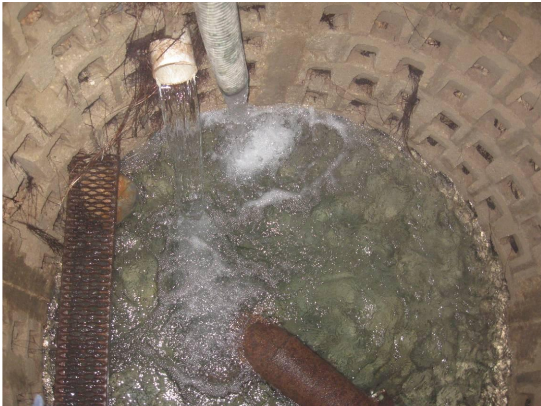
תמונות 73 ו-74: בתמונה העליונה מבט כללי אל אזור שוחת הבטון אליה מוזרמים מי עין משמר ועין שולמית. האתר מוקף בגדר ונעול. בתמונה התחתונה השוחה התת-קרקעית אליה מוזרמים מי שני המעינות בצינורות נפרדים (במעלה התמונה). מנקודה זו מוזרמים המים בצינור תת-קרקעי אחד (בתחתית התמונה) לאורך תוואי נחל משמר.
