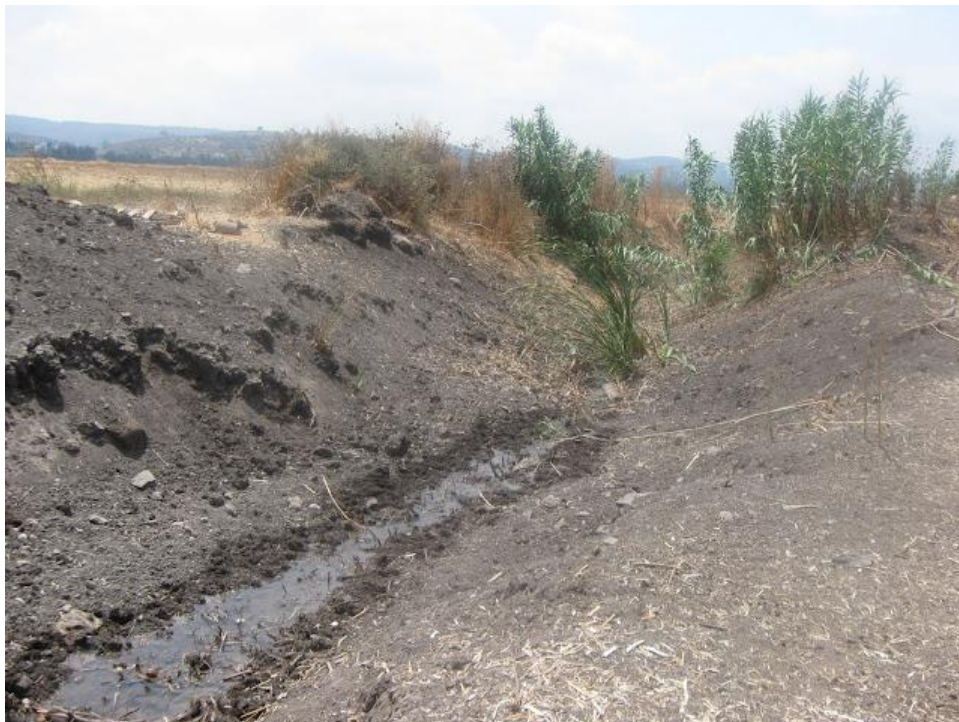
תמונות 128 ו-129: בתמונה העליונה הבריכה וסכר העפר במורד עין בדים. התמונה צולמה בביקור השני לאחר פעולות ההסדרה (25.06.2012). בתמונה התחתונה נראית חלק מהתעלה לאחר פעולת העמקה וכיסוח של הגדות.
