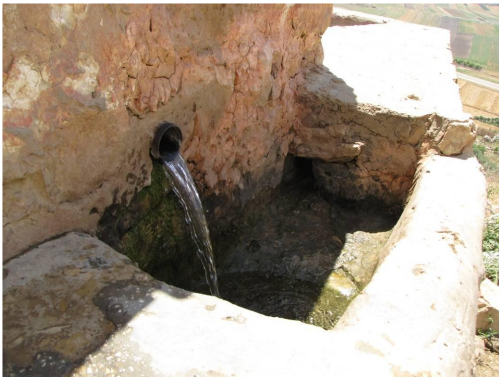
תמונות 78 ו-79: בתמונה העליונה מבט אל בריכת הבטון הריקה ממים ואל השוקת. ניתן לראות צינור פלסטיק שחור מחובר אל השוקת ומוביל את המים לחלקות החקלאיות במורד. בתמונה התחתונה צילום מקרוב של השוקת וזרם המים של המעיין. בנקודה זו בוצעה מדידת הספיקה.
