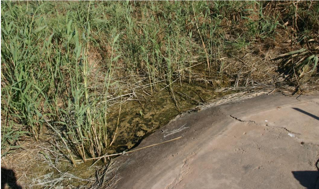
תמונה 194: בתמונה אפשר לראות שלוליות שנוצרות כתוצאה מהזליגה של המים מחוץ לבריכת הבטון.
