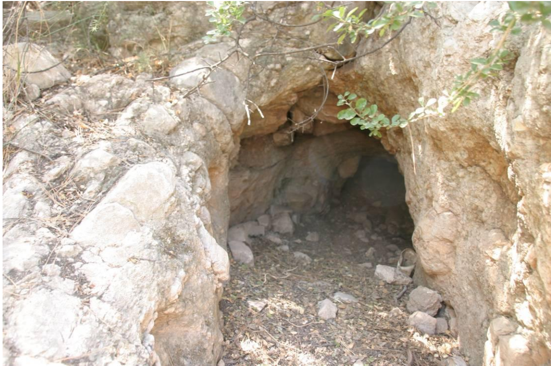
תמונה 94: בצילום פתח הנקבה של עין המורה. המים זרמו בעבר מהנקבה דרך תעלה קצרה לבריכה קטנה ממנה היו אוספים אותם תושבי כפר נין.
