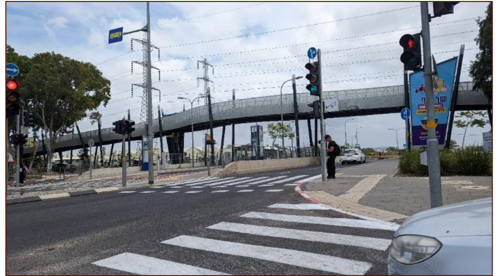
גשר הגדורה ממשיך הטיילת מעל כביש 781 1
